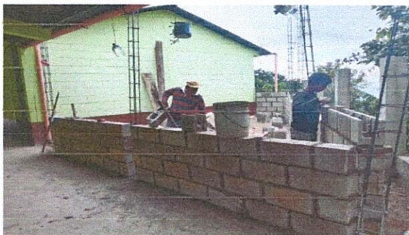
Foto1: Mejoramiento de aula estilo pórtico, con entechado de lamina troquelada, alisado de piso e instalacion de energia.
