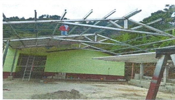
Foto 2: Mejoramiento de Cubierta de Patio
